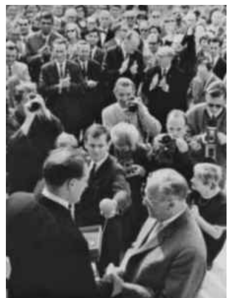
Schlüsselübergabe in der Komischen Oper Berlin, 1966. Oberbauleiter Walter Schwarz (links) und Intendant Walter
